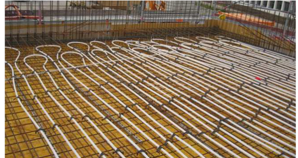
beispiel: rohrbefestigung auf der unteren bewehrung
